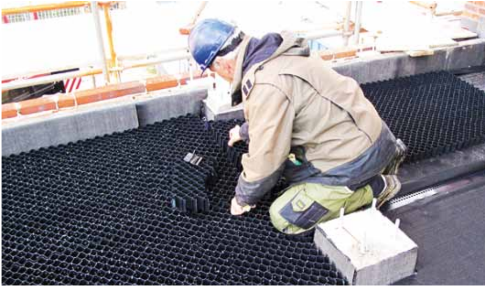
Het dak kan tijdelijk 80 liter water per vierkante meter bergen.
