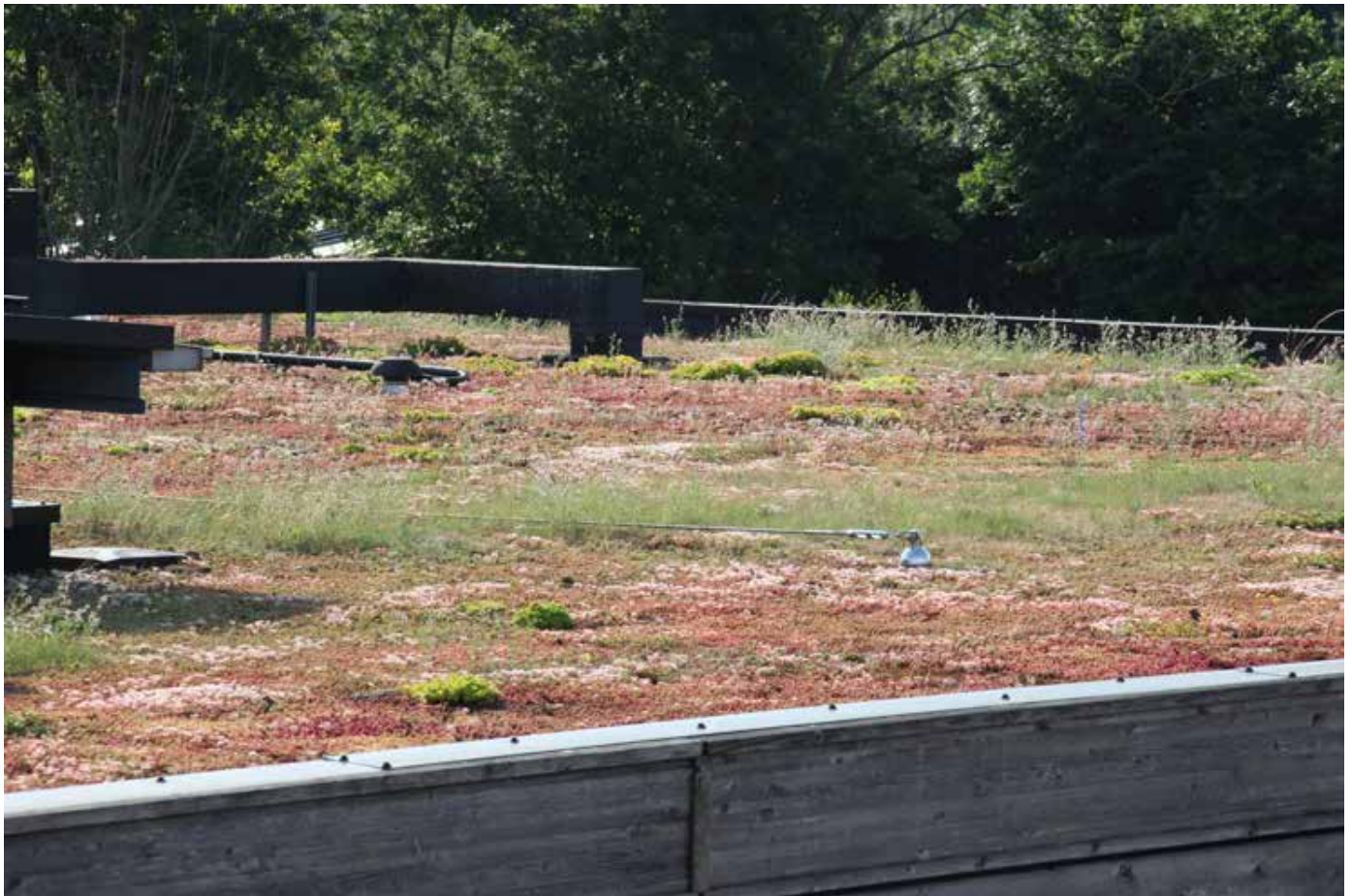
Foto 3. De begroeiing op het dak zonder zonnecollectoren wordt gedomineerd door Sedum. Foto: Petra van den Berg, juni 2019.
